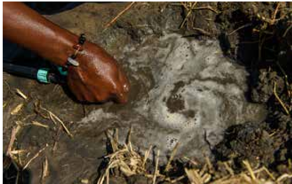
Ami répare un tuyau qui fuit.
